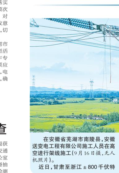
在安徽省芜湖市南陵县，安徽送变电工程有限公司施工人员在高空进行架线施工（9月16日摄，无人机照片）。近日，甘肃至浙江±800千伏特高压直流输电工程安徽段进入架线施工阶段。据悉，甘浙特高压工程是国家“十四五”电力发展规划重点项目，起于甘肃省武威市，止于浙江省绍兴市，全长约2370千米；投运后将有效促进西部“沙戈荒”大基地清洁能源外送，缓解华东地区电力供需矛盾，每年可向浙江输送电量超360亿千瓦时。
