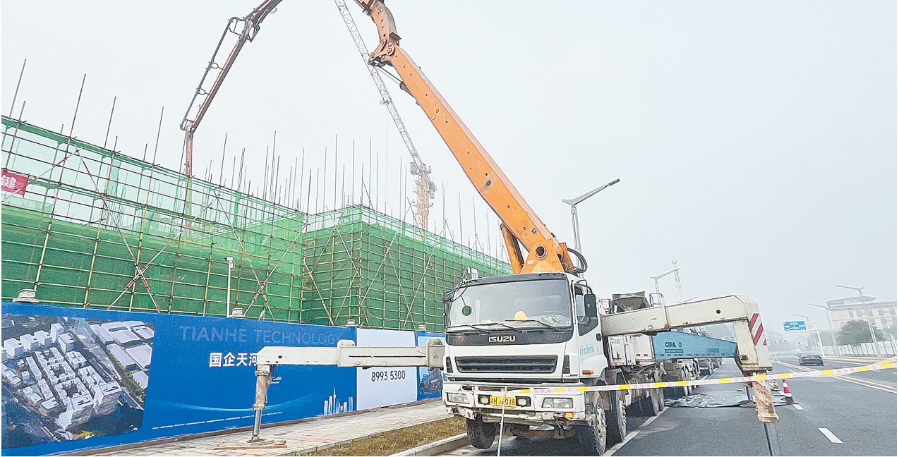
工地建设热火朝天
