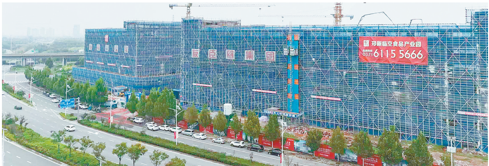
正在建设的郑新临空食品产业园
