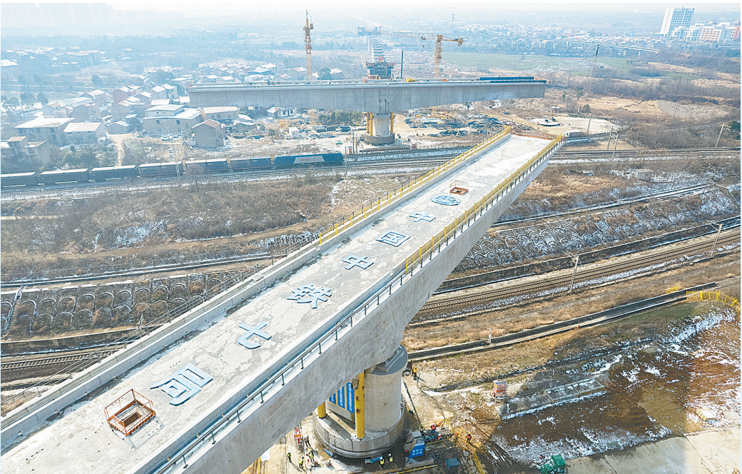
图为1月22日拍摄的合武高铁塘埠口瀑水特大桥跨京广铁路转体施工现场。1月22日,由中铁七局承建的合武高铁塘埠口瀑水特大桥跨京广铁路转体桥完成转体施工,为工程的下一步建设打下坚实基础。合武高铁是国家中长期铁路网规划的重要项目,建成后将进一步完善沿江综合交通运输体系,大幅缩短武汉至合肥的运行时间。 新华社记者 肖艺九 摄
