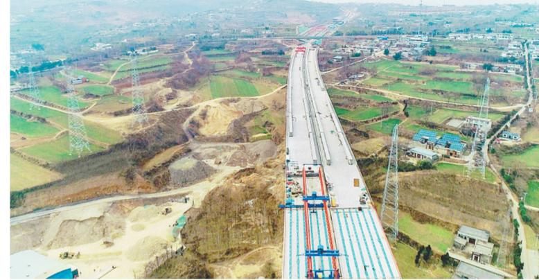
大型机械联合作业,已完成总工程量的92%。作为项目建设的重中之重,桥梁工程各节点呈现“快慢并进、多点突破”的推进态势。主线跨G343分离式立交桥施工现场,桥墩整齐林立,桥面铺装有序推进,工人正在高空作业平台上有序施工。据了解,该座桥梁桩基、下构工程均已100%完工,桥面铺装完成24联,占总量的70.6%。
