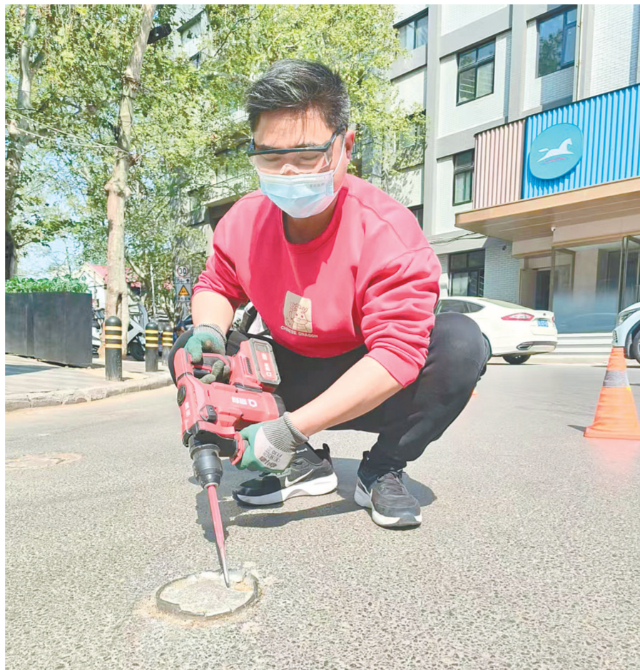
小帅用电锤敲碎残桩旁路面
