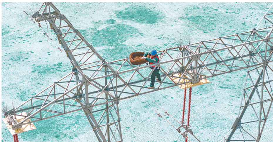
在位于新疆阿勒泰福海县的乌兰古湖国家湿地公园,国网阿勒泰供电公司工作人员在固定生态鸟巢(4月1日摄,无人机照片)。
