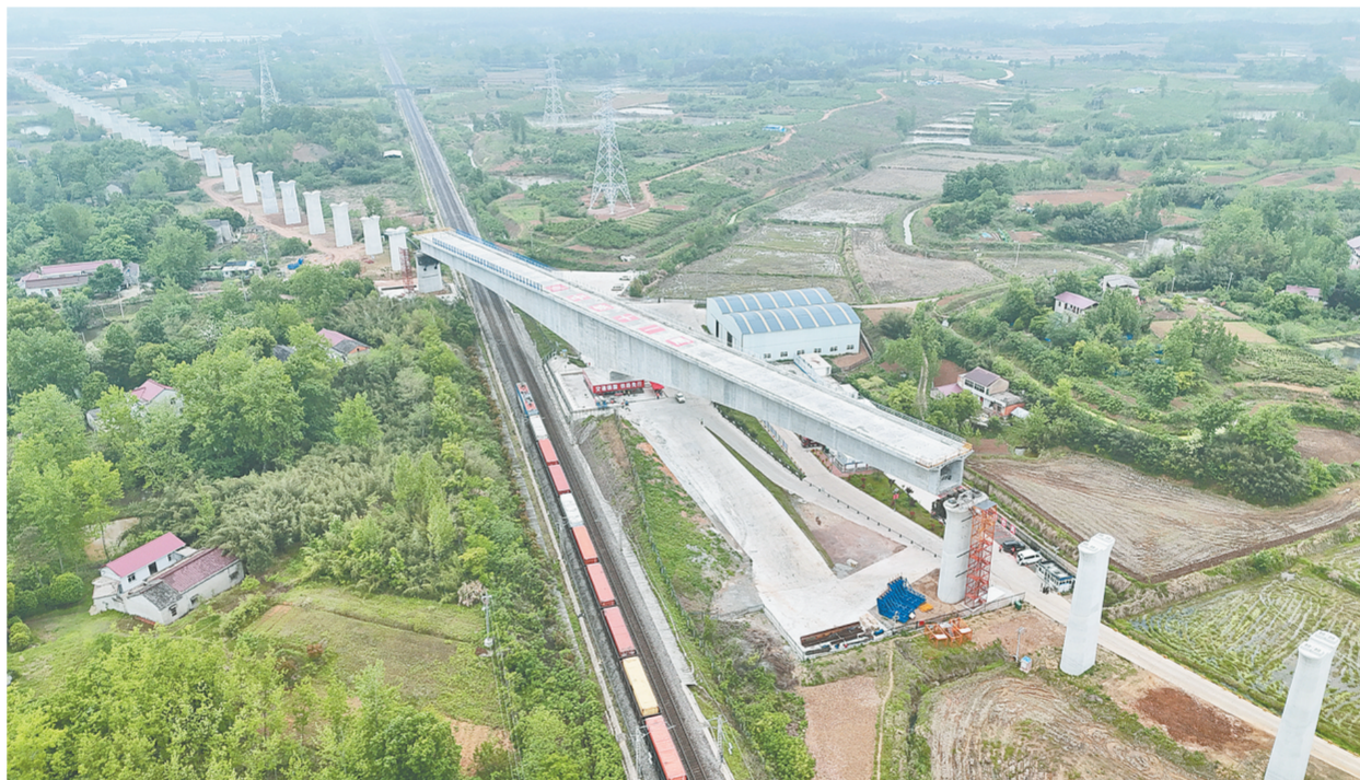
4月21日，在安徽省六安市叶集区境内，合武高铁跨宁西铁路特大桥230米T构连续梁成功完成20.47度“空中转体”，跨越宁西铁路。图为当日，在已完成转体的合武高铁跨宁西铁路万吨连续梁下方，列车在宁西铁路上行线(无人照照片)。
