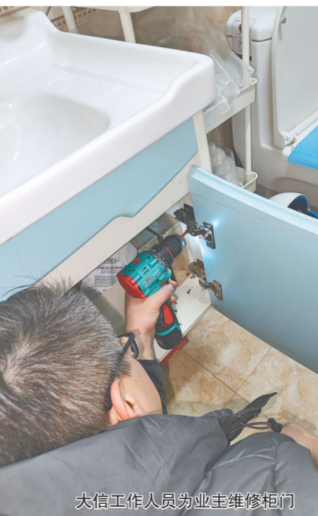
大信工作人员为业主维修柜门
