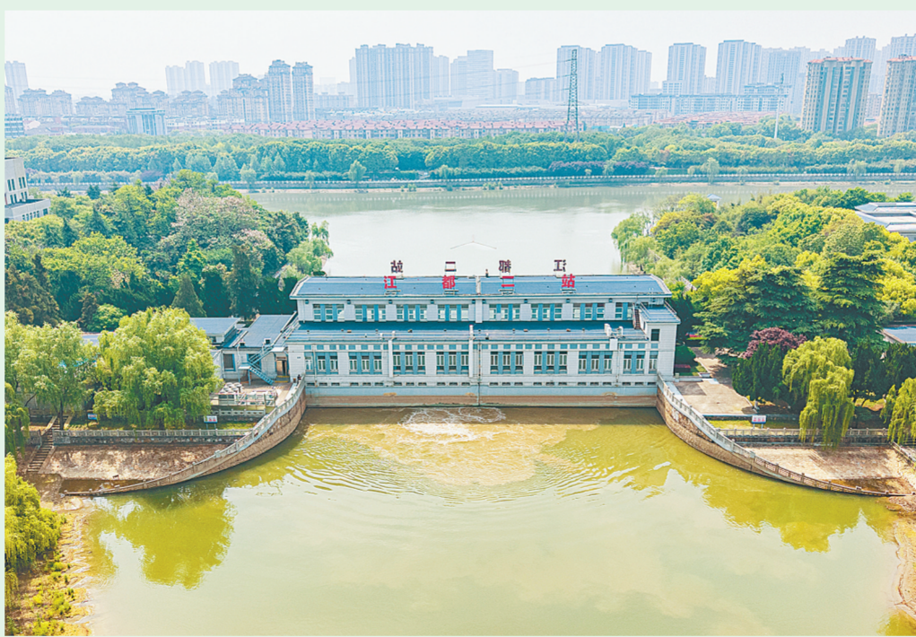
4月27日10时,根据南水北调东线一期工程2026年4月水量调度方案,江苏省江都水利枢纽工程管理处启动新一轮调水,南水北调东线应站同步启动调水。图为4月27日,位于江苏省扬州市江都区的南水北调东线源头江都水利枢纽二站启动调水(无人机照片)。
