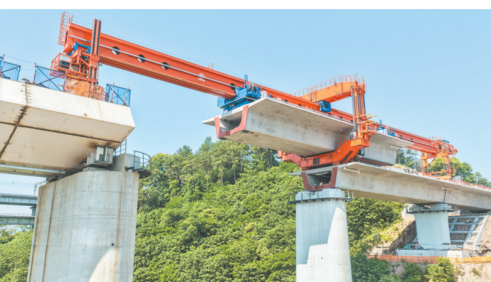
图为5月5日拍摄的成渝中线高铁架梁作业现场(无人机照片)。5月5日，随着中铁十二局架桥机将最后一根长32米、重约700吨的箱梁稳稳架设在成渝中线高铁嘉陵江特大桥引桥桥墩上，成渝中线高铁全线箱梁架梁任务圆满完成，为项目全线早日通车运营奠定了坚实基础。新华社记者 唐奕 摄
