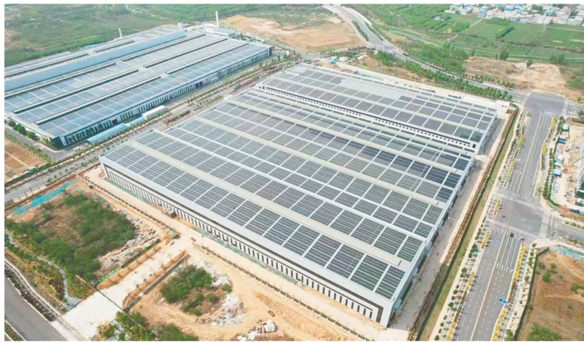
位于郑州高新区的河南鸿晟新材料科技有限公司厂房已封顶,正在进行全面生产扩产
