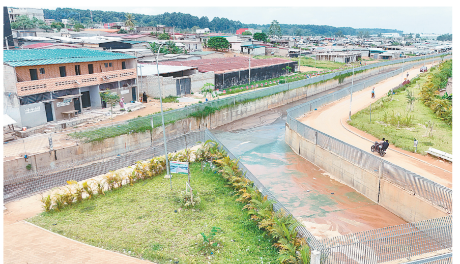
这是4月22日在科特迪瓦经济首都阿比让北部阿波波区拍摄的新修建的排水渠(无人机照片)。新华社发(中国电力建设集团有限公司供图)
