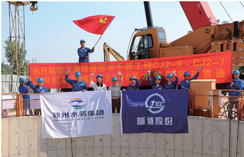
郑开同城郑州东部原水主干管工程成功穿越直径3米污水主干管
