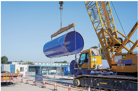
郑开同城郑州东部原水主干管工程管材吊装现场
