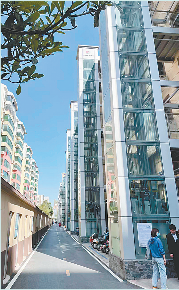
既有住宅加装电梯,老人上下楼不再难
