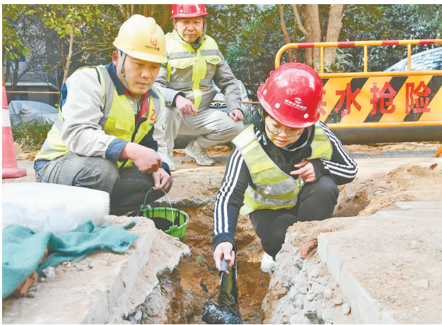
本报记者(右)体验自来水管刷沥青防腐。本报记者周雨摄
