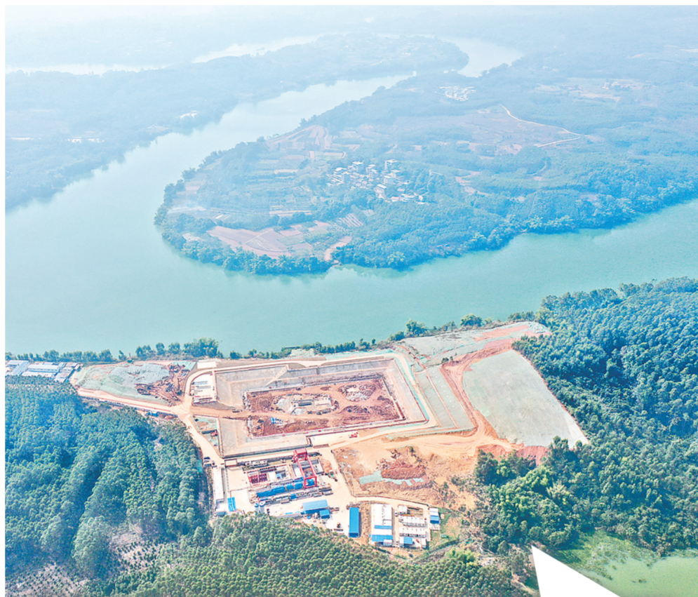
广西南宁市邕江上游二期引水和应急引水工程项目建设现场（无人机照片，12月2日摄）。当日，广西南宁市邕江上游二期引水和应急引水工程隧洞工程盾构机顺利始发。据介绍，南宁市邕江上游二期引水和应急引水工程是广西重点推进的重大项目，工程修建供水管线总长度28.2公里，总投资56.1亿元。项目建成后，将提升南宁市供水应急保障能力。新华社记者 陆波岸 摄
