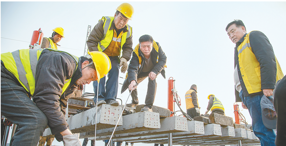
集中修施工现场
