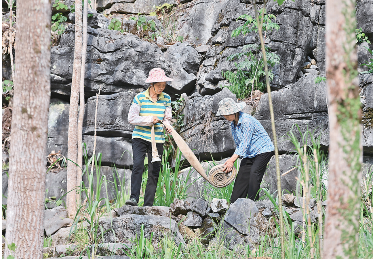
4月21日，广西马山县金钗镇龙印村村民在铺设水管，准备将当地政府送来的水引进水柜。日前，广西部分地区出现不同程度旱情，造成部分群众出现饮水困难和农作物受灾。自治区水利厅决定自4月19日18时启动旱灾防御三级应急响应，各地正积极采取措施，全力做好抗旱工作。
