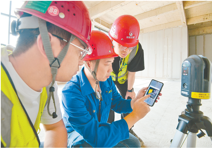
通过三维激光扫描对房屋主体结构实测实量
