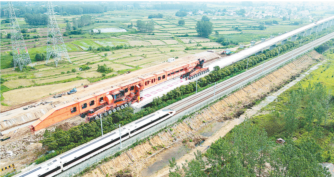
新建沪宁合高铁安徽段站前四标最后一幅 40 米箱梁完成架设(6 月 25 日摄,无人机照片)。 6 月 25 日凌晨,随着最后一幅重达 930 吨的 40 米箱梁架设完成,由中国铁建大桥局承建的新建上海至南京至合肥高速铁路安徽段站前四标 517 幅箱梁架设全部完成,为后续无砟轨道施工奠定基 据悉,新建上海至南京至合肥高速铁路是国家中长期铁路网规划“八纵八横”中沿江通道的重要组成部分,是江北沿江城市与南京都市圈、上海都市圈快速直达的快捷通道。
