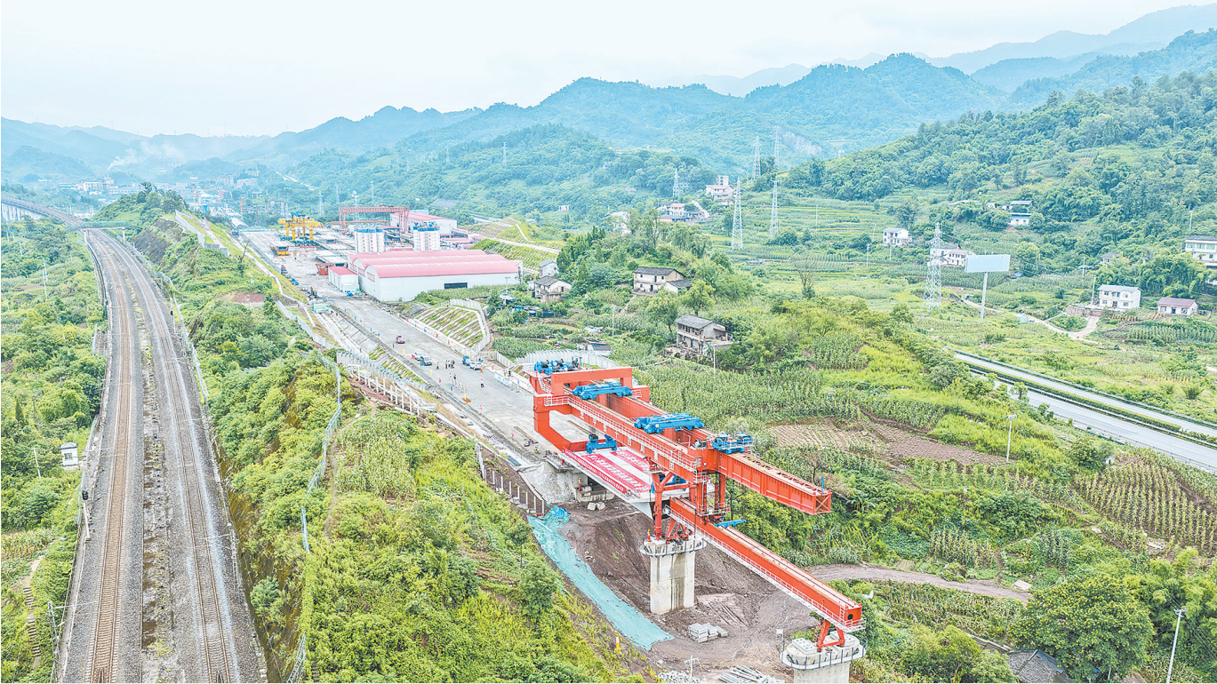
7月10日,在西渝高铁陈家沟特大桥建设现场,架梁机在进行首孔箱梁架设作业(无人机照片)。当日,中铁十四局工人将首孔长24.6米、重542吨的箱梁架设在西渝高铁重庆段陈家沟特大桥第一孔桥墩上,标志着西渝高铁重庆段箱梁架设施工正式启动。 西渝高铁是西安到重庆的高速铁路,全长739公里,设计时速350公里,是我国“八纵八横”高铁网京昆通道和包(银)海通道的重要组成部分。 新华社记者 唐奕 摄
