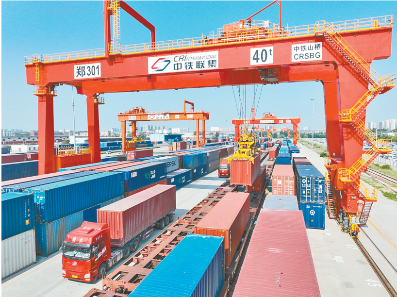
圃田车站正在进行集装箱吊装作业
