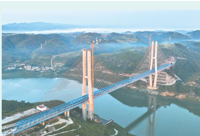
8月18日,由中铁十一局承建的西安至十堰高速铁路(简称“西十高铁”)汉江特大桥顺利合龙。汉江特大桥位于湖北省十堰市,跨越丹江口水库库区,是西十高铁全线控制性工程,全长917.45米,主跨420米。本次合龙的钢桁梁全长840米、宽11米、高9.4米,采用渐变三角桁式结构,最重桁节36.4吨。西十高铁正线全长255.76公里,设计时速350公里,开通后,西安至十堰将实现1小时内到达。 新华社记者 程敏 摄
