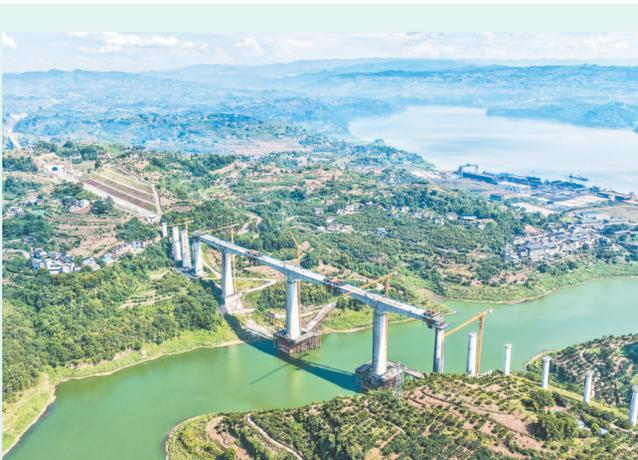
8月18日,由中国铁建大桥局承建的重庆至万州高速铁路(渝万高铁)渠溪河双线特大桥顺利合龙。渝万高铁渠溪河双线特大桥位于重庆市涪陵区珍溪镇,横跨长江支流渠溪河,全长953米,是全线重难点工程。渝万高铁是我国“八纵八横”高铁网包(银)海、京昆通道的组成部分,正线全长251公里,设计时速350公里。 新华社记者 唐奕 摄
