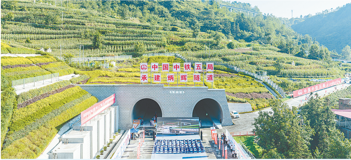
空中俯瞰渝昆高铁炳辉隧道(8月19日摄,无人机照片)。
